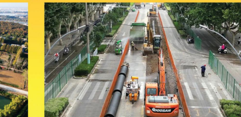
供水管网提升改造工程建设
