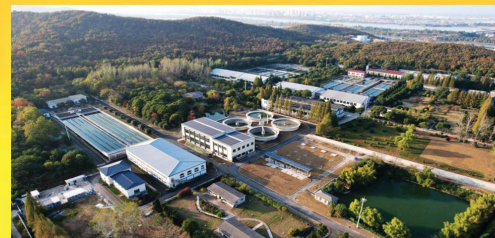
黑虎山水厂污泥干化项目建成并投入运行，该项目荣获2024年度“中国节能美丽中国建设·安全环保标准化示范工地”称号
